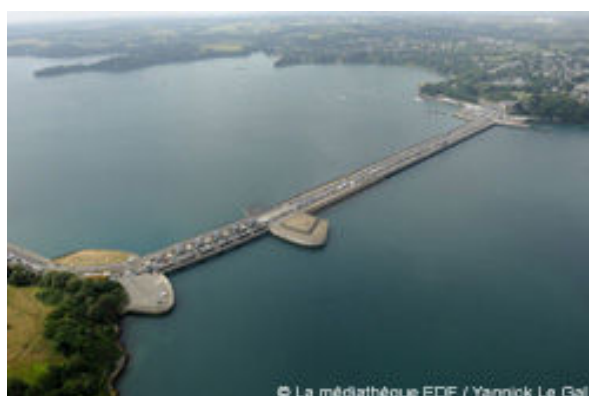
usine marémotrice de la Rance (35) Elle produit chaque année 4 % de l'électricité consommée en Bretagne
